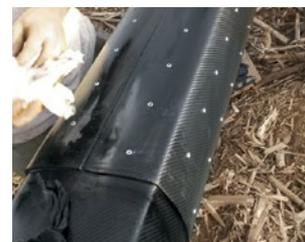
Des sections neuves en fibre de carbone, fournies dans le kit de réparation, sont coupées afin de s'adapter à la section endommagée de la rampe.
